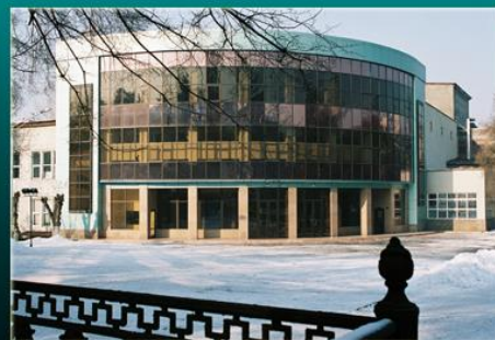
Уйгурский театр после проведения модернизации фасада здания
